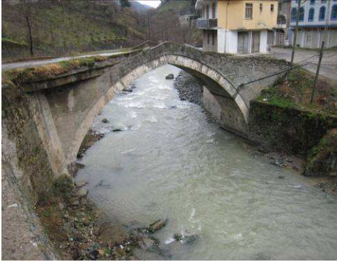
Foto 42: Bifara Köprüsü Memba Cephesi
