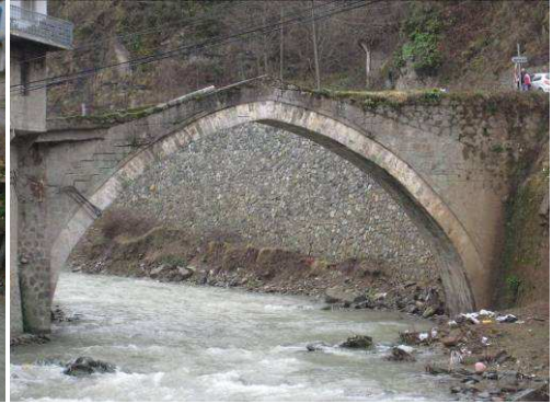
Foto 43: Bifara Köprüsü Mansap Cephesi
