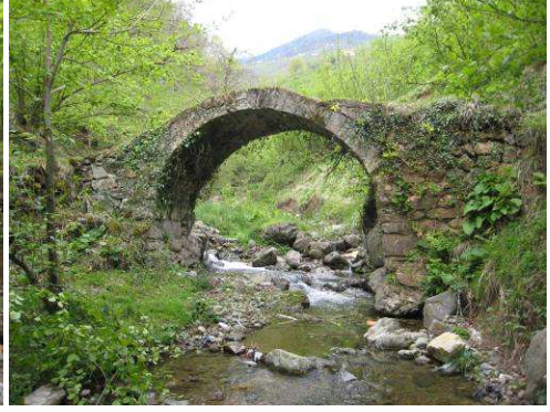
Foto 45: Dağbaşı Yolu İrmak Köprüsü Mansap Cephesi
