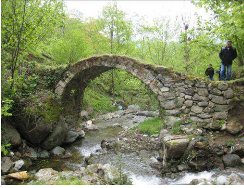
Foto 44: Dağbaşı Yolu İrmak Köprüsü Memba Cephesi
