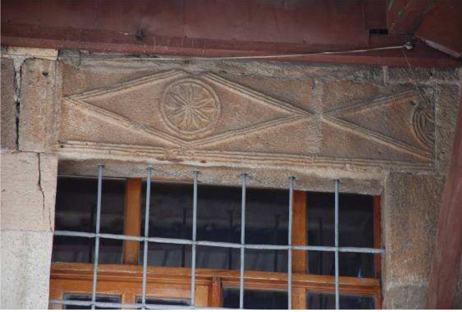
15. Fotoğraf: Doğu cephede pencere lentosu olarak kullanılan devşirme parça.
