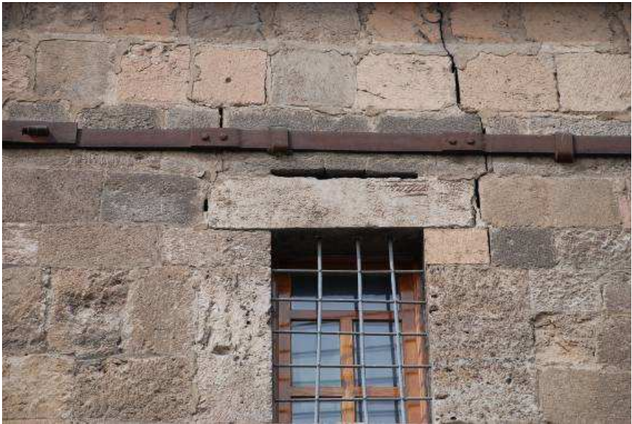
12. Fotoğraf: Doğu cephede devşirme malzeme kullanımı.
