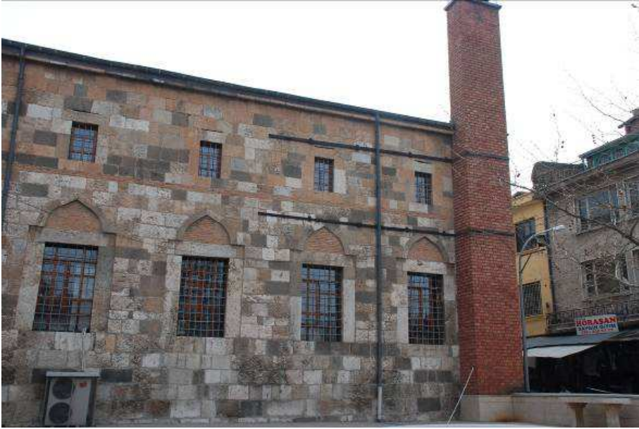
8. Fotoğraf: Batı cephede tuğla kullanımı ve metal kuşaklar.
