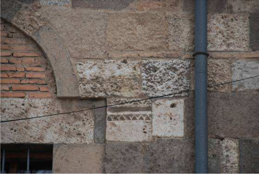
9. Fotoğraf: Batı cephede yer alan devşirme malzeme örneği.
