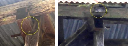
Foto. 14-15. Malakmiyet Köprüsü'nde “kanallı geçme” ayrıntıları
