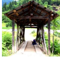
Foto. 5. Malakmiyet Köprüsü güneybatı girişi
