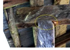
Foto. 16. Malakmiyet Köprüsü'nde “zıvanalı geçme”
