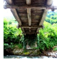
Foto. 6. Malakmiyet Köprüsü tabliye altı - güneybatı yaka
