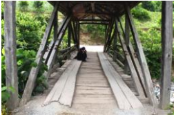
Foto. 7. Malakmiyet Köprüsü tabliyesi - kuzeydoğudan
