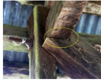
Foto. 10-11. Malakmiyet Köprüsü'nde "kertmeli uç birleştirme" ayrıntıları
