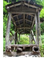
Foto. 26. Baltacılar Köprüsü güneydoğu girişi
