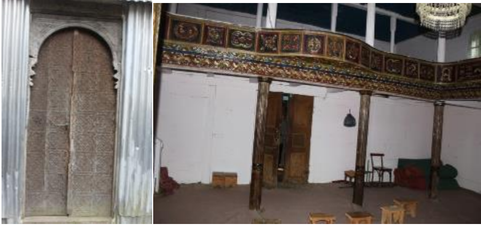
Resim 41- Yapının özgün giriş kapısı
