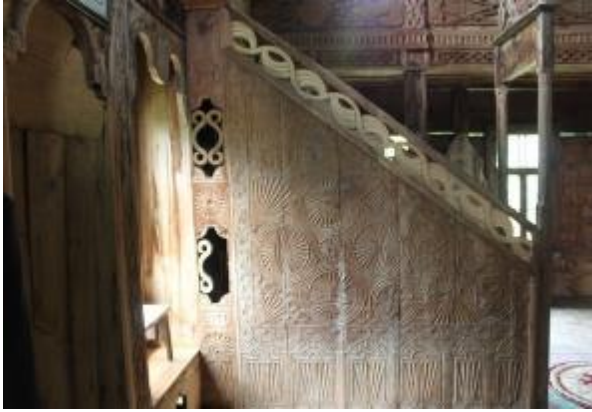
Resim 29- Yapının minber aynasının görünümü
