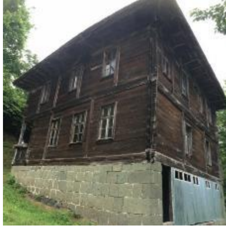
Resim 26- Kveda Agara Camii'nin güneybatıdan görünümü
