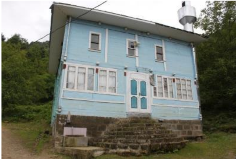
Resim 16- Hohna Camii'nin giriş cephesinden görünümü.
