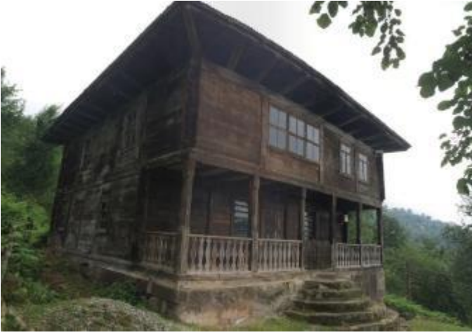
Resim 3- Uchkhiti Camii, (kuzeydoğu cephe).
