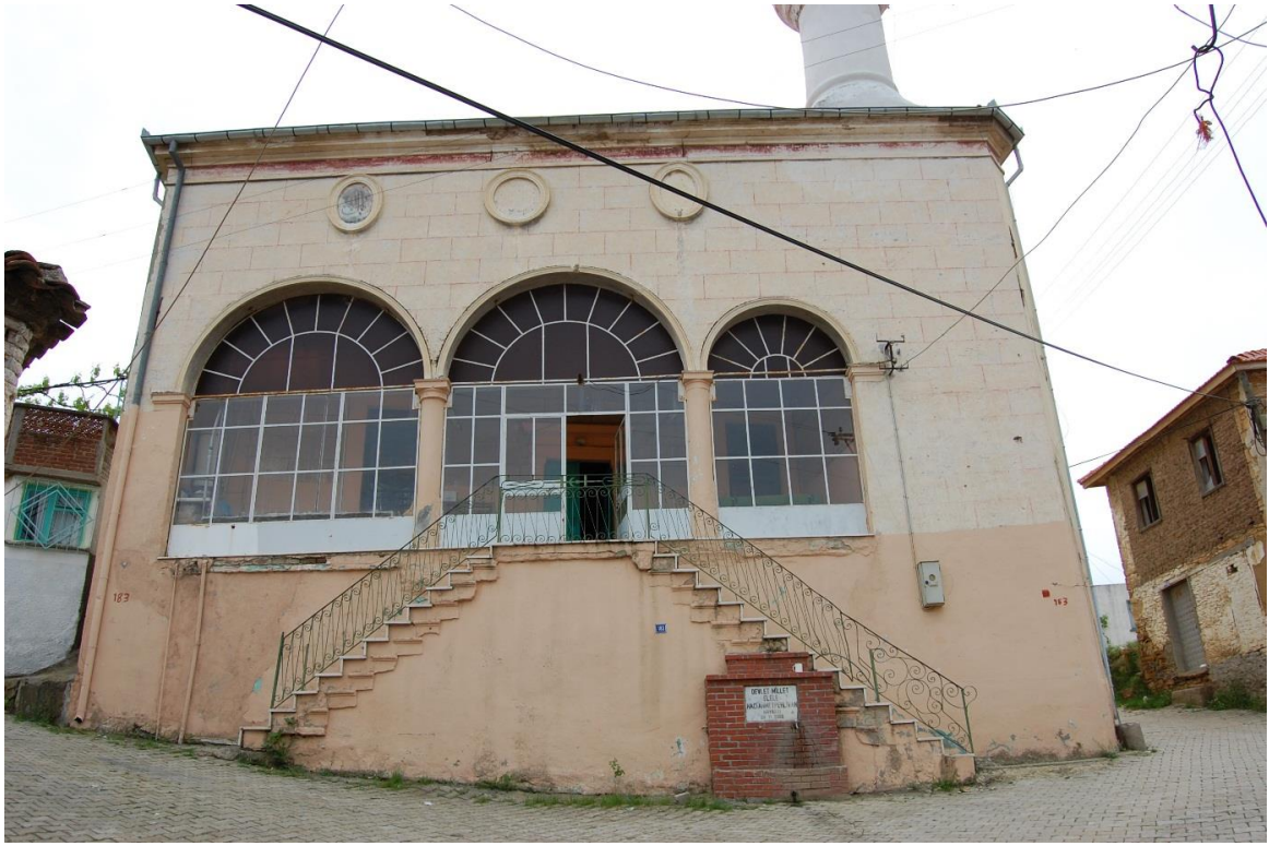
Fotoğraf -1. Caminin kuzey cepheden görünümü
