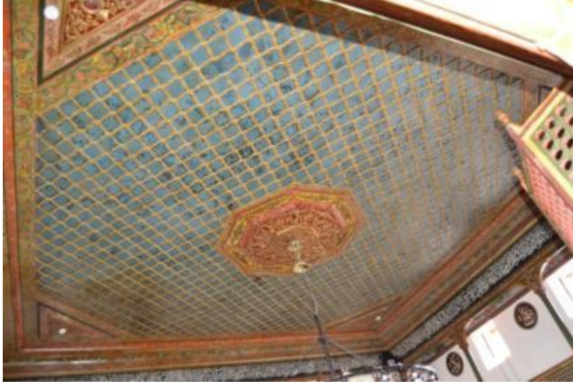
Foto.: 20 - Zile Elbaşıođlu Camii Ahşap Tavan (Restorasyon Sonrası).
