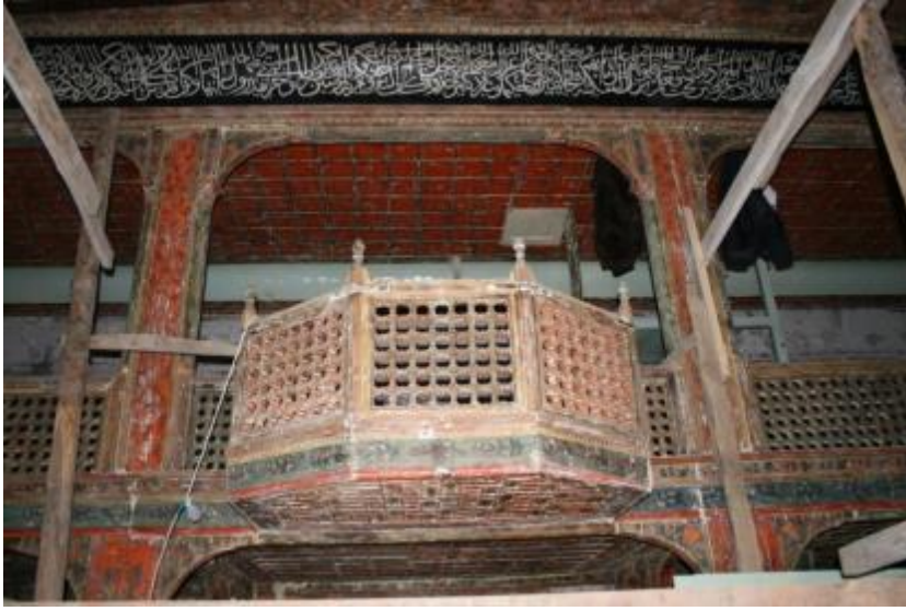
Foto.: 13 - Zile Elbaşoğlu Camii İçeriden (Restorasyon Esnası).
