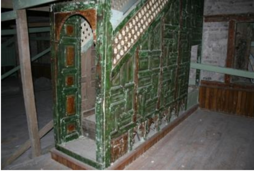
Foto.: 10 - Zile Elbaşođlu Camii Minber(Restorasyon Esnası).
