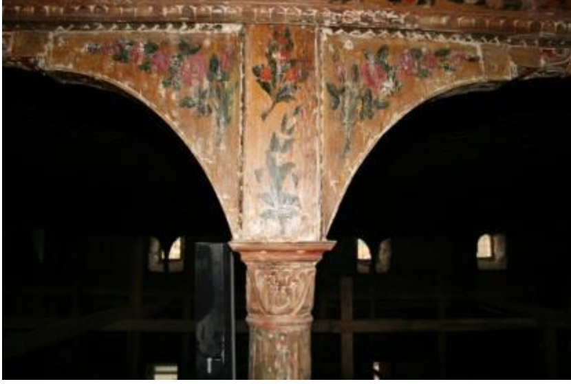
Foto.: 9 - Zile Elbaşođlu Camii Ahşap Taşıyıcılar (Restorasyon Esnası).
