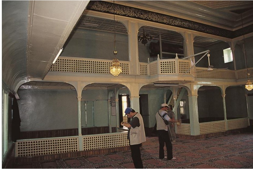
Foto.: 6 - Zile Elbaşođlu Camii İeriden (Restorasyon Öncesi).
