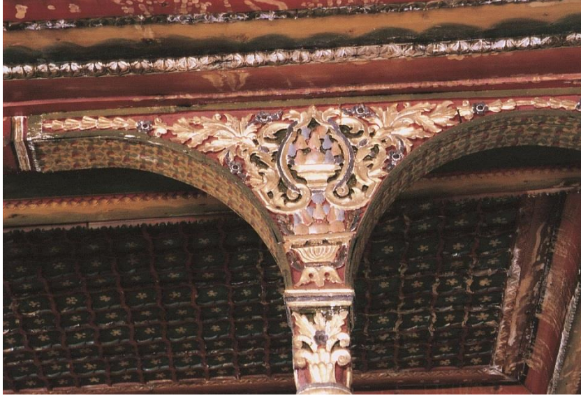
Foto.: 31 - Yađcıođlu Konađı Ahşap Taşıyıcı.
