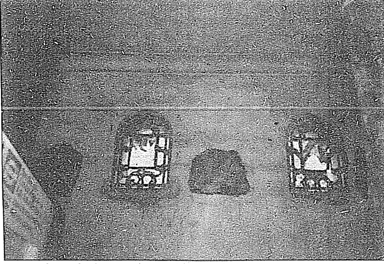
Resim 6 - Kırk camlı alçı tepe pencereleriyle sökülen dokuma tezgahlarının bağlantı yerleri izleri.
