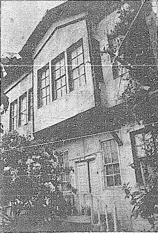
Resim 13 - Şeyh evi harem daresi giriş cephesi
