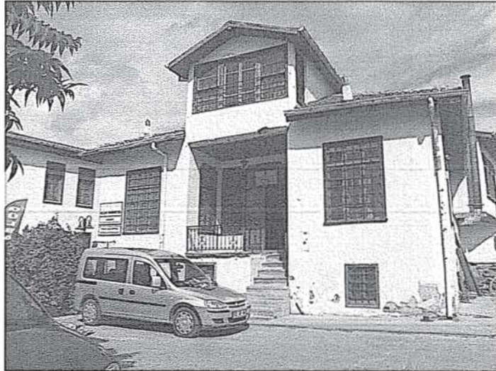
Resim 11: Eski Selçuklu Araştırmaları Merkezi Cihannüma Görünüş
