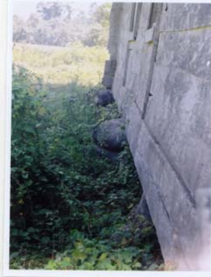
Resim:2 Caminin köşelerde ve aralarda kalaslar üzerine oturduğu havalandırma düzeni.
