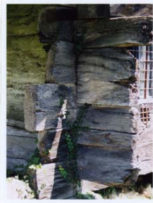
Resim:3 Karaboğaz yöntemi ile kalasların birleştirilmesinden görünüm. Güneybatı köşesi.
