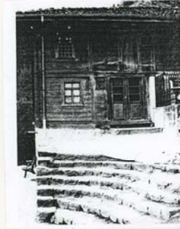
Resim:28 Rize- İkizdere İlçesi Güneyce- Hacı Şeyh Camisi (H. Karpuz'dan).
