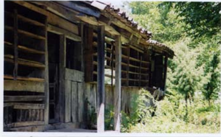
Resim:9 Doğu cephesinde revak kısmı.
