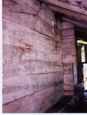
Resim:5 Doğu cephesinden görünüm.
