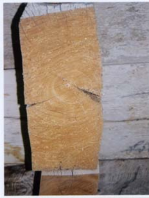
Resim:23 Dendrokronoloji yöntemi ile 1204, 1205 ve 1211 yıllarının belirlendiği diğer ağaç kesiti.
