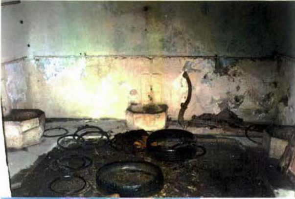
Sıcaklık bölümünde kurna taşları ve bugünkü hâli
