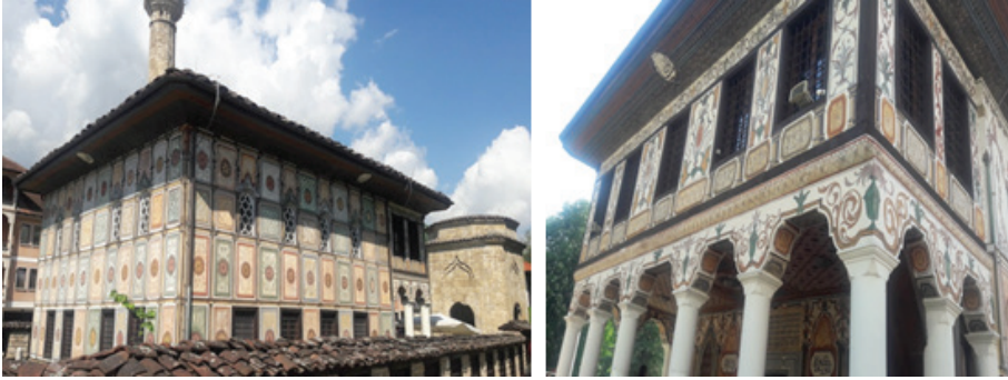
Resim 2. Solda Alaca Cami güney ve doğu cephesi, sağda kuzey cephesinden görünüm ve dış cephe süslemeleri.
