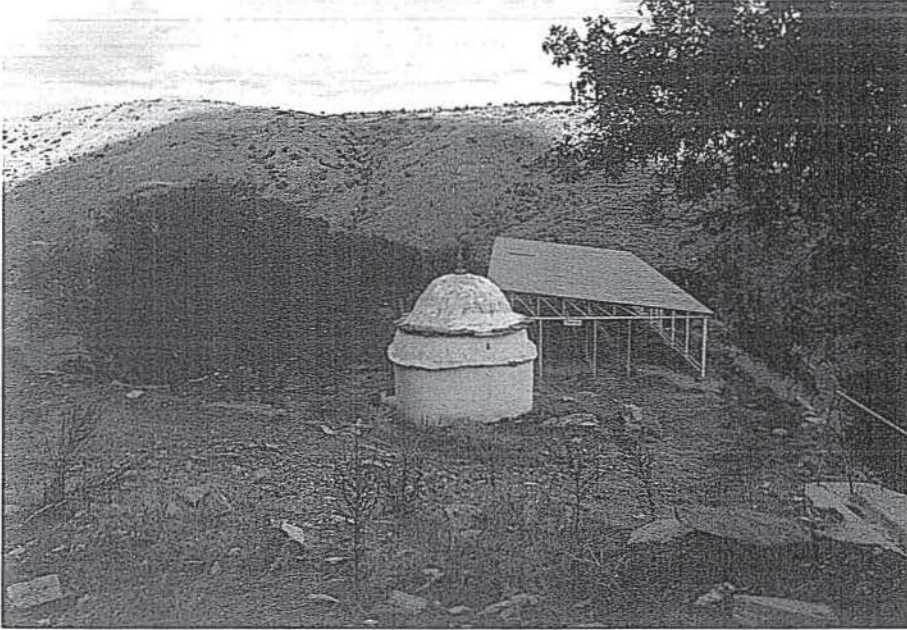
Çalçakırlar Köyünde Dümülcü Sultan Türbesi
