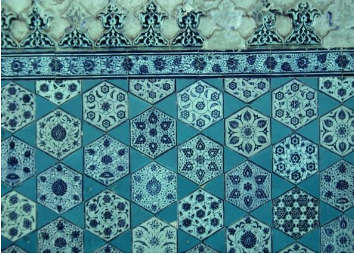
Foto. 16- Edirne Muradiye Camii, harim duvarları.
