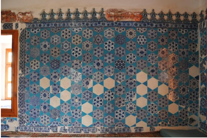
Foto. 16- Edirne Muradiye Camii, harim duvarları.
