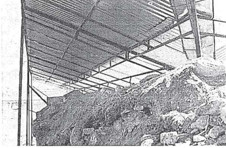
Res.15- Profil iskelete kaplanan galvaniz, oluklu saçlar.
