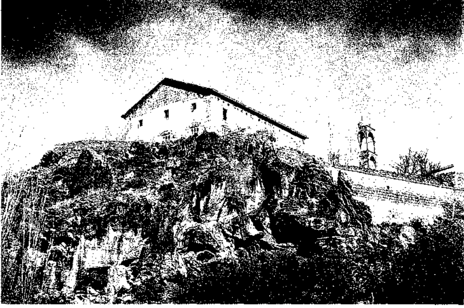
Resim 5 : Yeşilburç Kilise, güneybatı cephe ve çan kulesi
