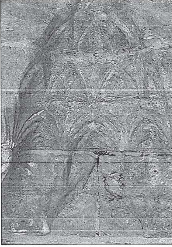
Resim 17 Şeyh Şeyhullah Camii. Giriş Mekânı (Selsebîlli Eyvan), Niş Düzenlemesi, 2016.
