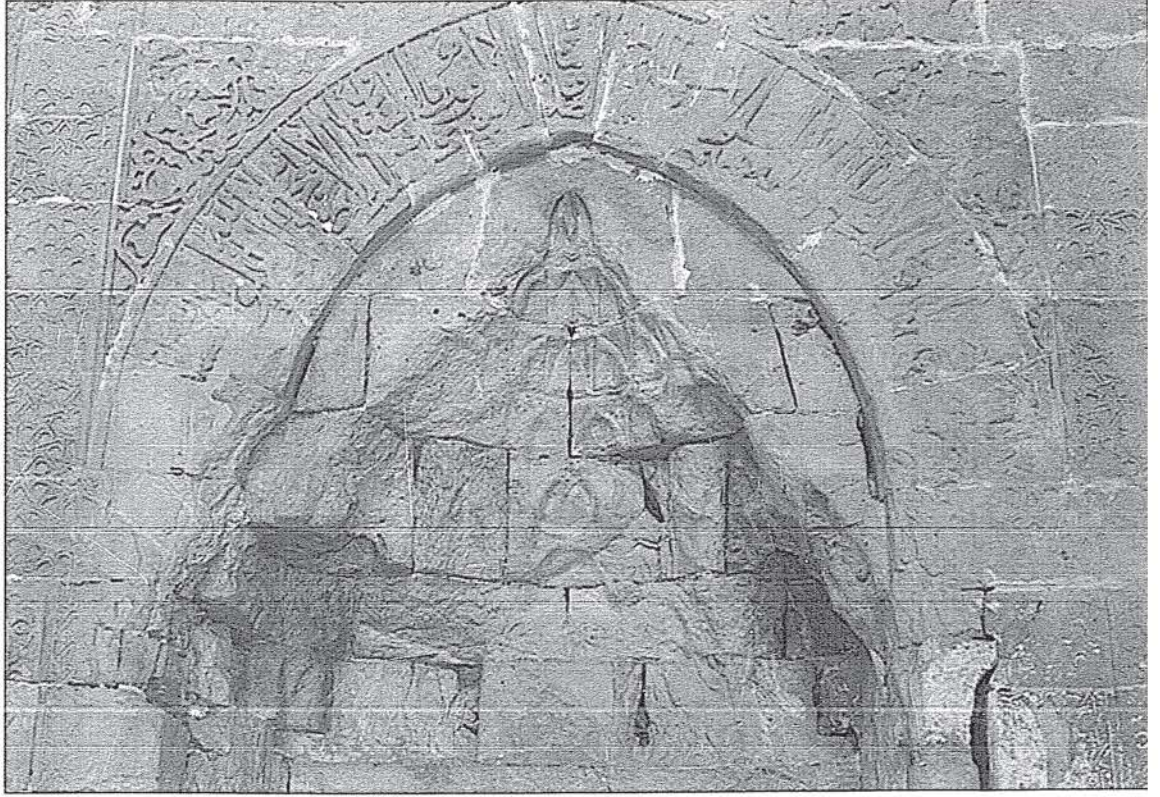
Resim 32 Zinciriye Medresesi, Mescid Giriş Kapısı. İçten Görünüş, 2016.
