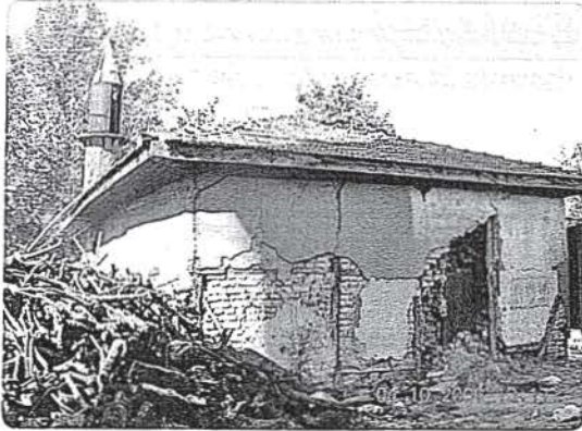
Resim 47a-b. Öküz Battı Mescidi duvar örgüsü onarım öncesi ve sonrası (VGMA,20:2006).
