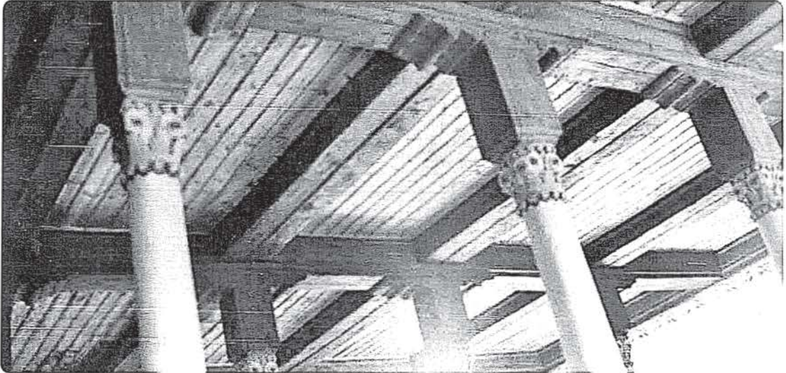
Resim 4. Kale Cevher Paşa Câmî Ahşap Kirişler ve Profilli Yastıklar (VGMA,20: 2006).
