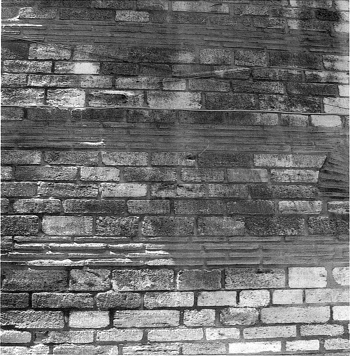
Resim 7. Mescidin almaşık duvar tekniği (M.Sav, 28.06.2012)
