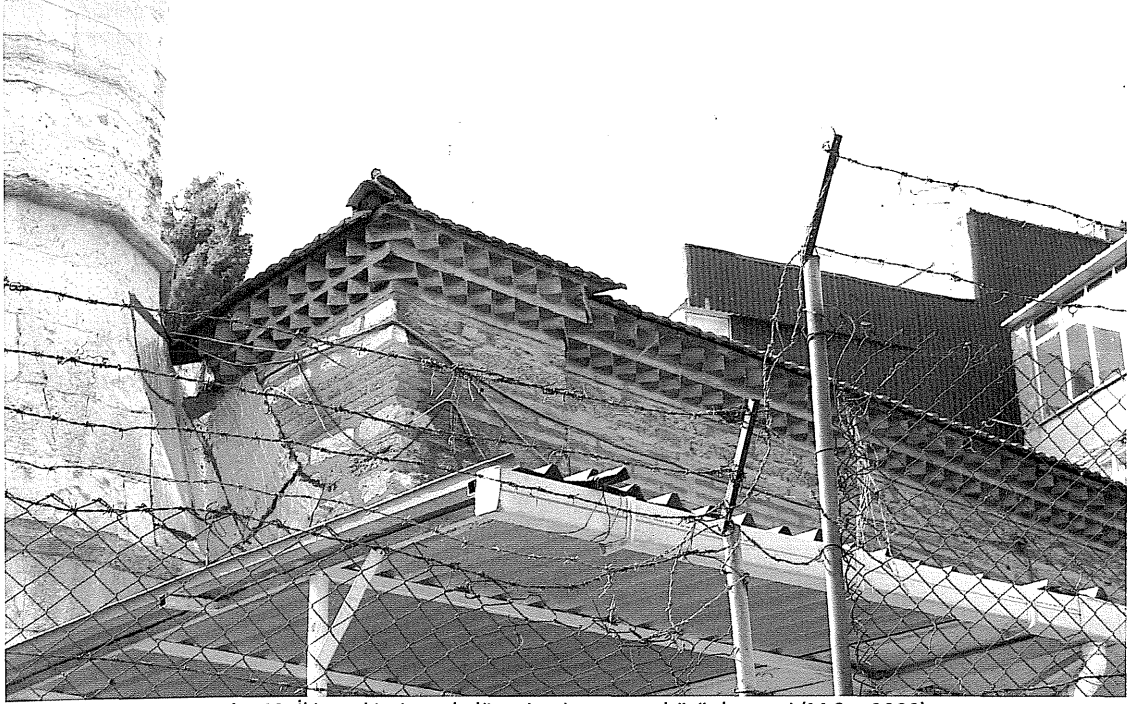
Resim 13. İki sıra kirpi saçak düzeni, minare yapı bütünleşmesi (M.Sav,2008)
