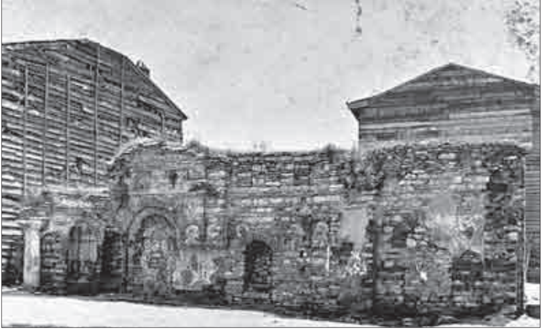
Resim 11. Kalıntı halinde iken güney duvarı ve mihrabı, apsisteki sütun ve ahşap yapılar
