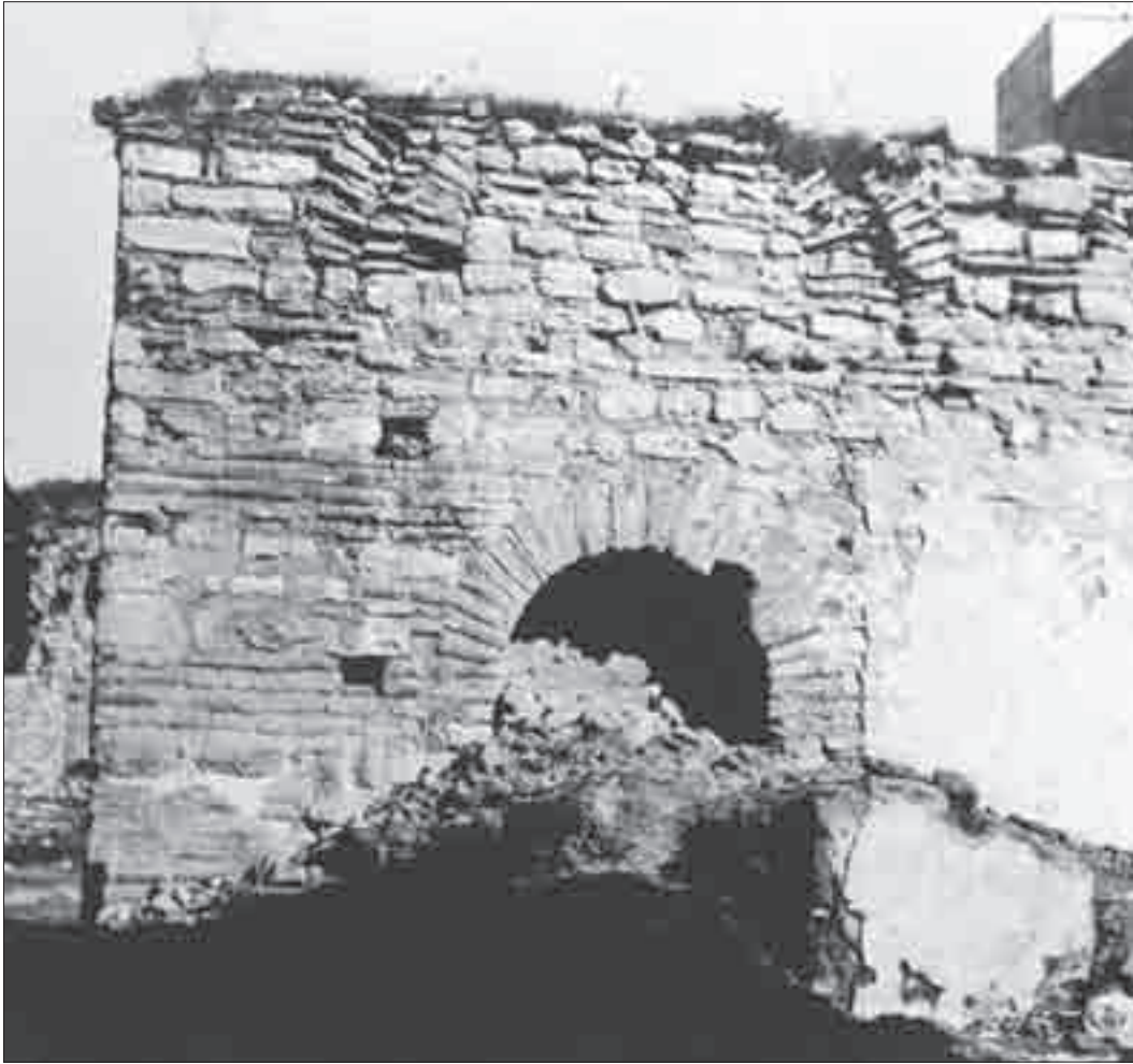
Resim 10. Yıkıntı haldeyken çekilen bir fotoğrafta cephe düzeni (Alman Arkeoloji Enstitüsü)
