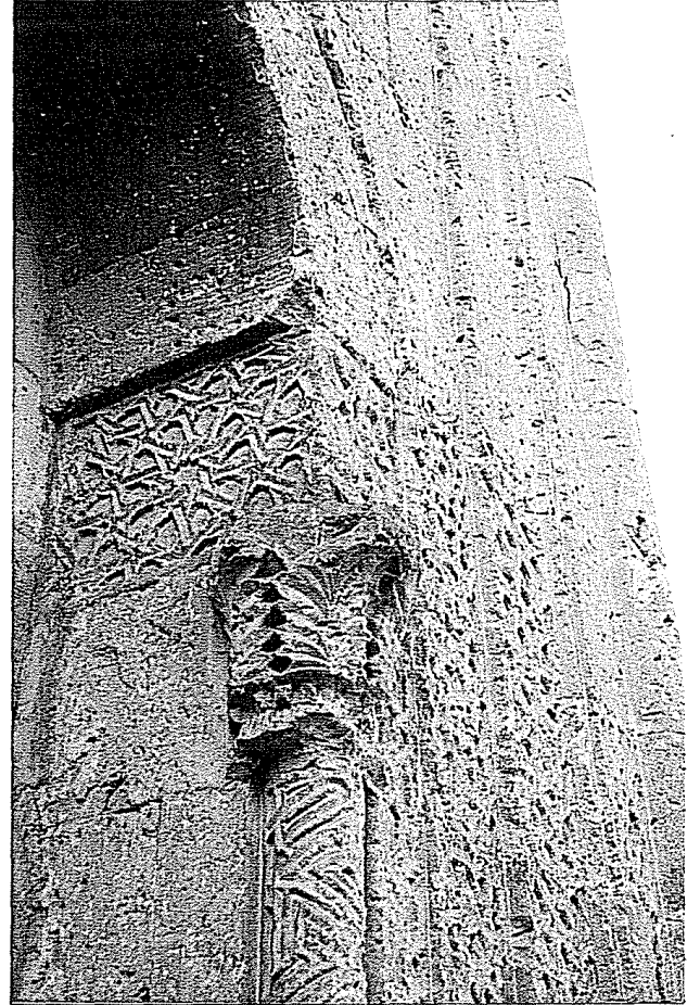
Res. 5: Köşk Medrese Türbesi sütunçesi üzerinde mimar kitabesi
