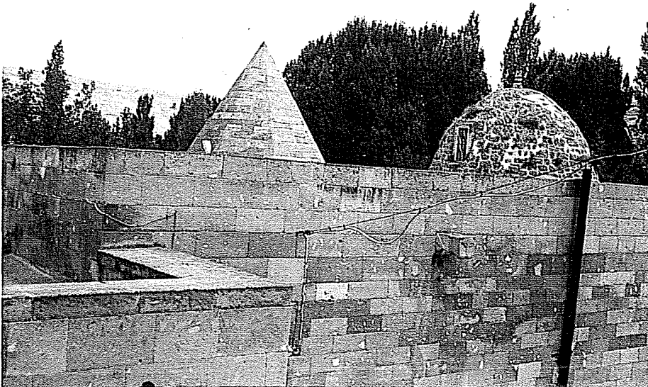
Res. 16: Taşkın Paşa Camii kubbesi ve türbesinin külâhı
