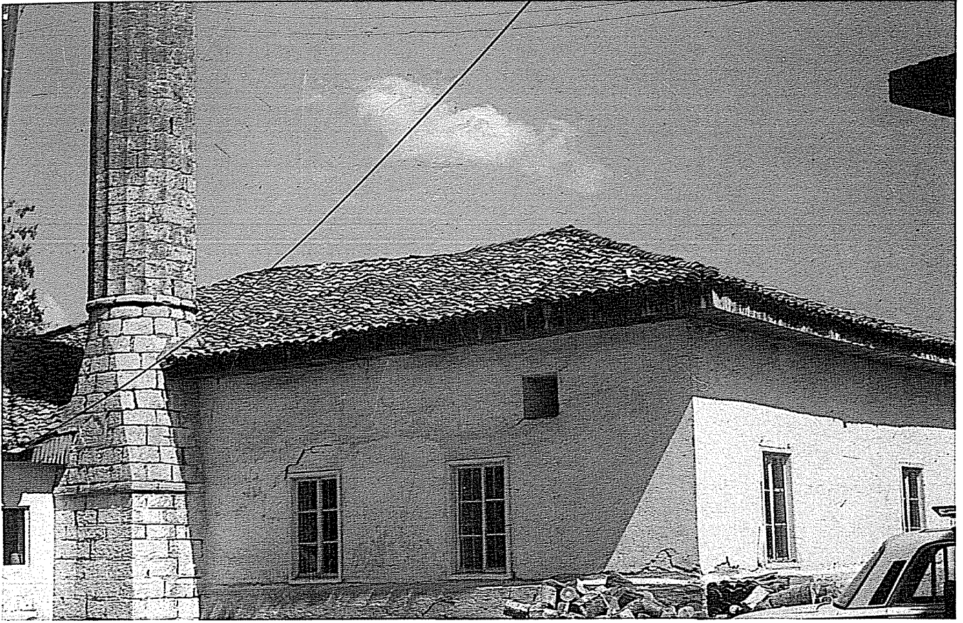
Resim 10: Struga Halveti Tekkesi'nde cami yapısı.
