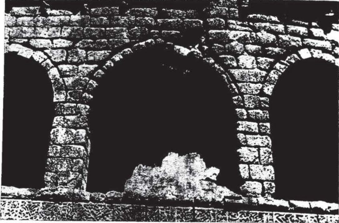
Res. 8 — Mesudiye Medresesi, üst kat arkadlarından görünüş.
