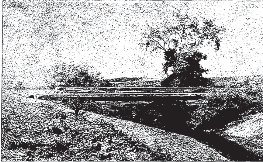
Res. 2 — İnceik köprüsü 1962 yazında.
