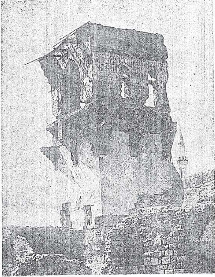
Res. 9 — Köşk yıkılmadan önce (kuzey ve batı yüzü).
