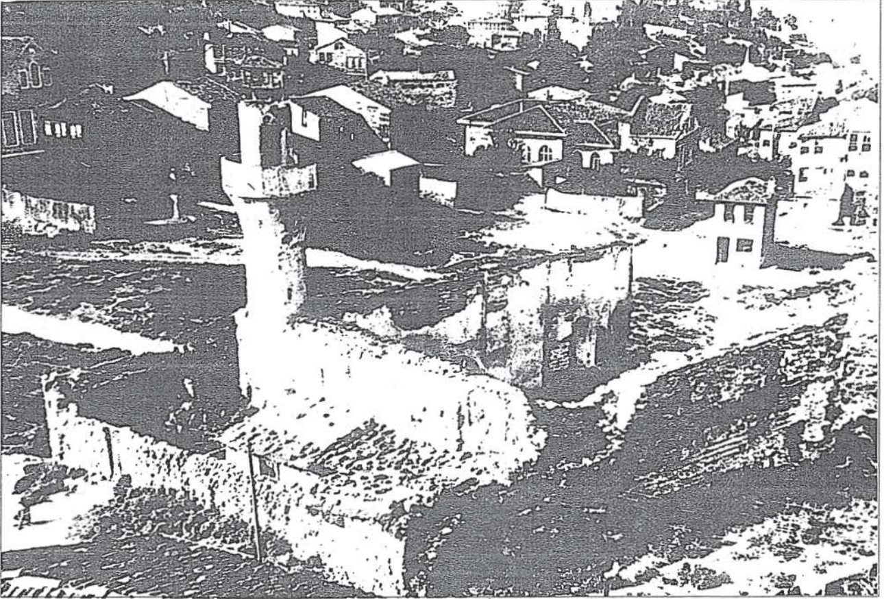
Odalar Camii'nin yangın sonrası, Kasım Ağa Camii minaresinden görünüşü.
