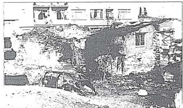
Odalar Camii harabesinin 1973 yılındaki durumu.
