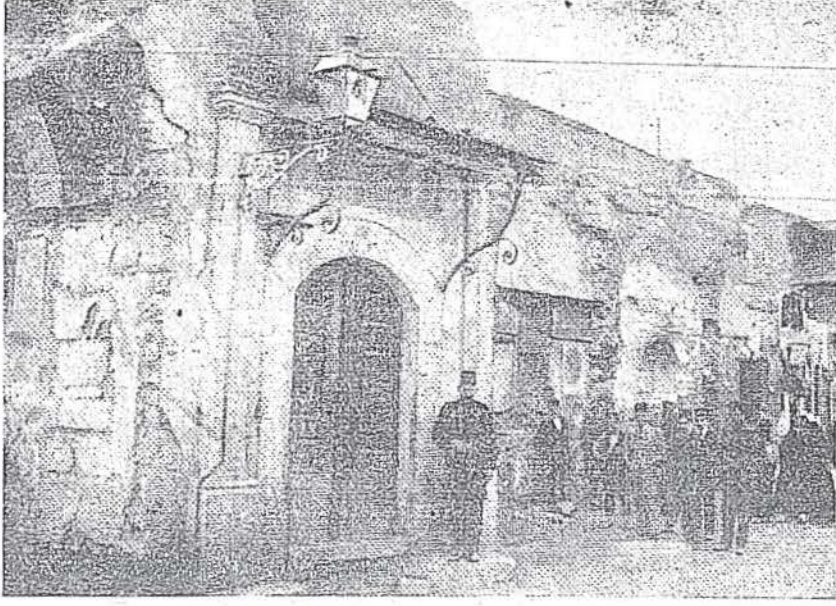
Medresenin sokağa açılan kapısı (eski bir fotoğraftan)
