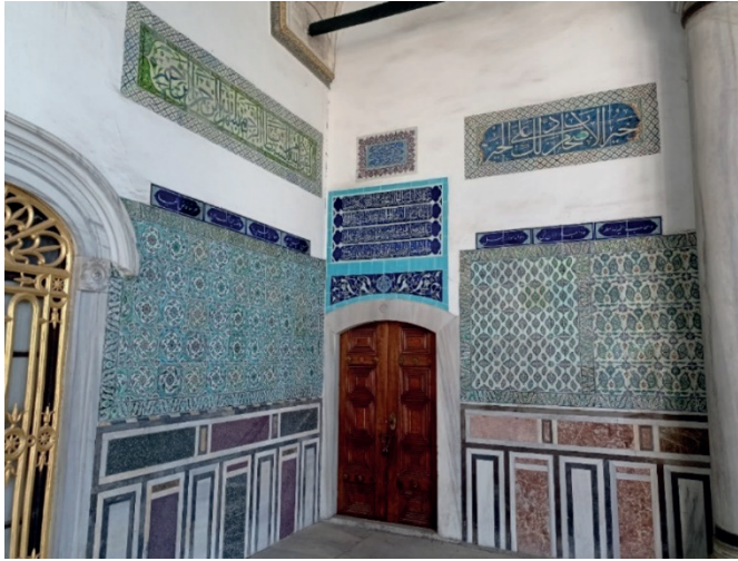
Resim 24. Hırka-i Saadet Dairesi'nin Haliç'e Bakan cephesinde çini panolar.
