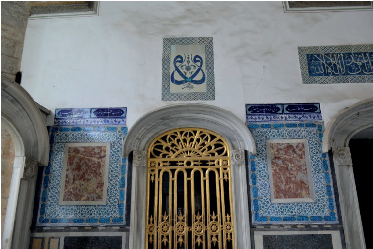
Resim 26. Hırka-i Saadet Dairesi'nin Revan Köşkü'ne bakan cephesinde çini panolar.
