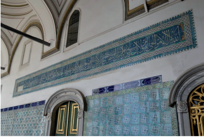
Resim 25. Hırka-i Saadet Dairesi'nin Haliç'e bakan cephesinde çini panolar.
