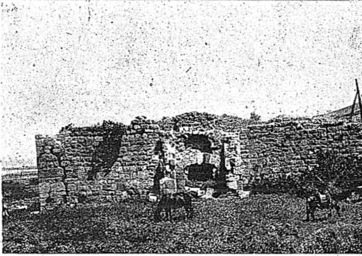
Şekil: 2 — Gelendost : Kudret Han cepheden görünüş.
