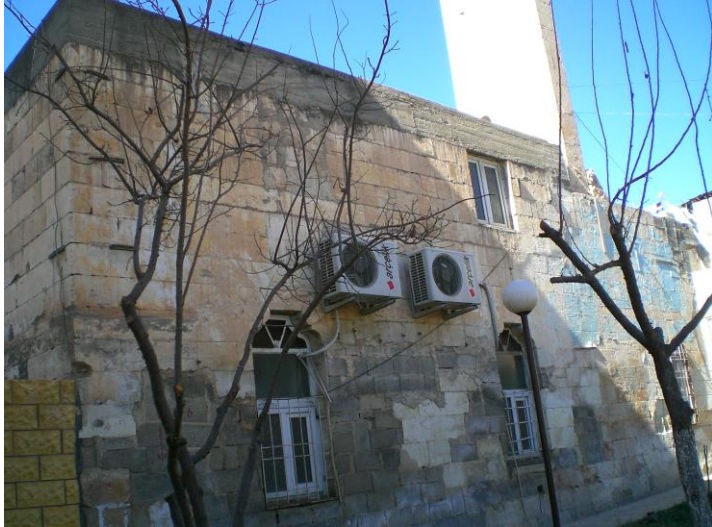
Res. 8, Nizip Saha Camii, doęu cephesi
