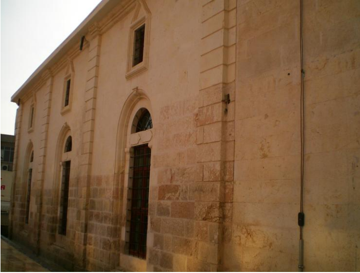
Res. 22, Nizip Çarşı Camii, doğu cephesi
