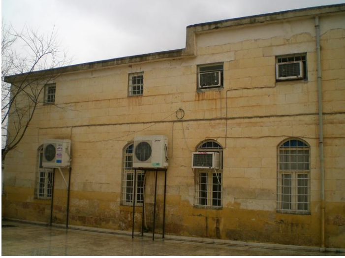
Res. 13, Nizip Şihlar Camii, doğu cephesi
