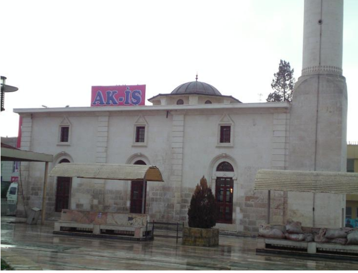
Res. 21, Nizip Çarşı Camii, güney cephesi
