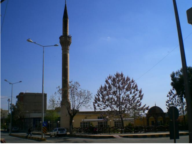
Res.1, Tahtani Camii, kuzey cephesi
